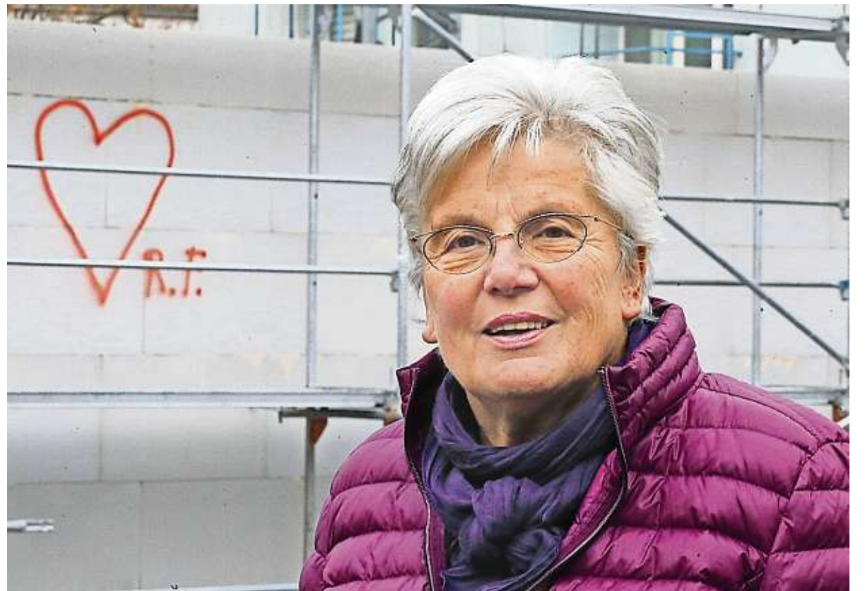
Buchstäblich ein Herz für Ria Flatt haben die Bauarbeiter, die an der Irenicusstraße eine neue Kindertagesstätte errichten. Sie ärgerte sich im November über die Rohbauwand ohne Fenster auf der Seite zu ihrer Dachterasse. Und siehe da, die Arbeiter verteilten die kahle Wand mit einem roten Herzen und ihren Initialen. FOTOS: KETTERL
